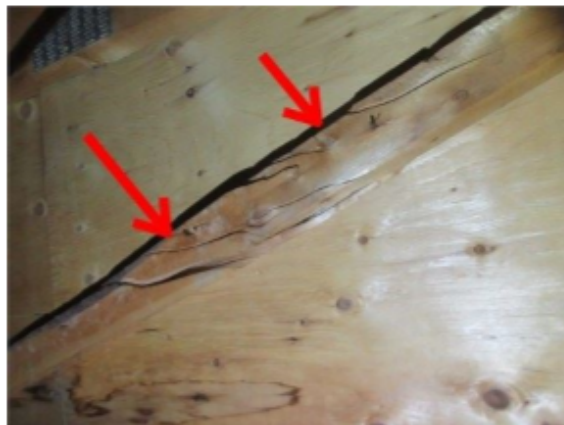
ferme de toit grandement affaiblie
